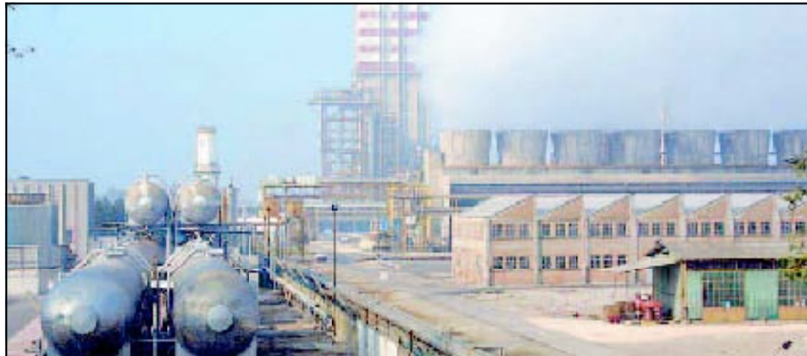
L'area del petrolchimico, dove dovrebbe sorgere la nuova centrale
